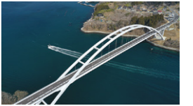
写真:気仙沼大島大橋
