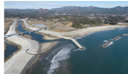
写真:令和3年3月 中島地区海岸災害復旧工事完成
