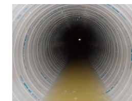
写真：令和元年度 管渠改築工事 河北桃生幹線(完了)
