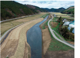
写真:南沢川 河川改修 堤防整備
