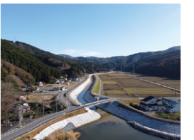
写真:一級河川北上川水系加茂川 改修工事完成
