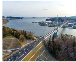
写真:三陸縦貫自動車道
