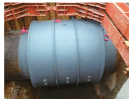
写真:令和2年度 伸縮可とう管補強工事(完了)
