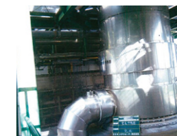
写真：平成30年度 仙塩浄化センター汚泥焼却施設(完了)
