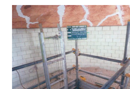
写真：令和元年度 仙塩浄化センター汚泥焼却施設(完了)
