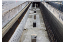
写真:工業用水 伸縮可とう管補強工事(完了)
