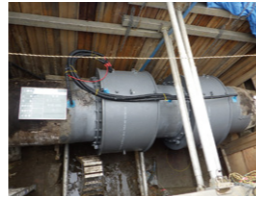
写真:平成30年度 仙南仙塩広水耐震補強工事(完了)
