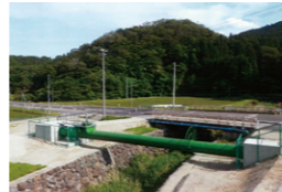
写真:令和元年度 送水連絡管 原前水管橋
