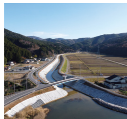
写真: 一級河川北上川水系加茂川改修工事完成
