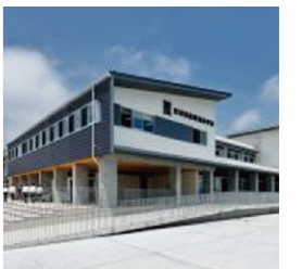
写真: 完成した農業高等学校
