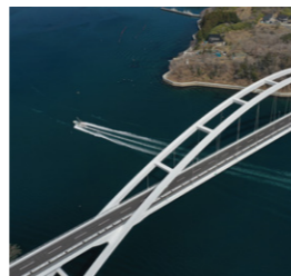
写真: 気仙沼大島大橋
