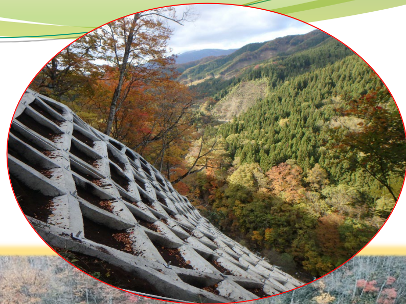
完成後の 法面状況
