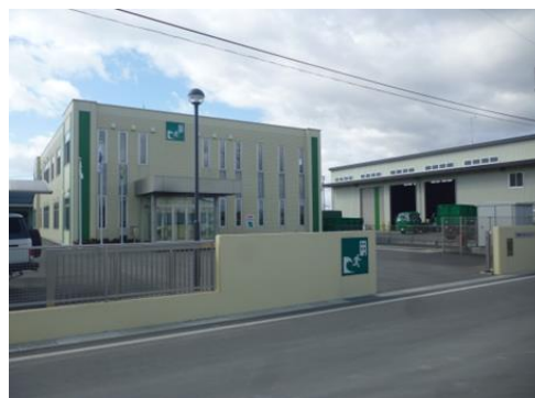
社屋／作業倉庫
