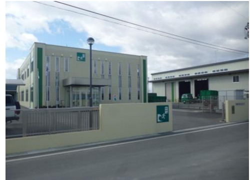
社屋／作業倉庫
