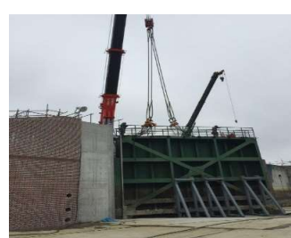
【水門ゲート据付現場】
