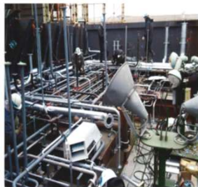
【 船内配管工事 】
