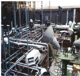
【 船内配管工事 】
