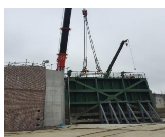
【水門ゲート据付現場】
