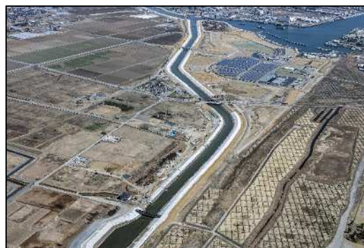
【南北上運河 工事完成】
