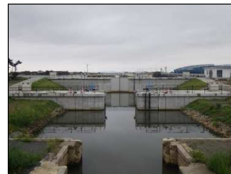
【釜閘門 工事完成】
