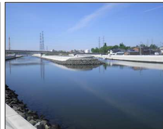
【御舟入堀工事 完成 旧砂押川】
