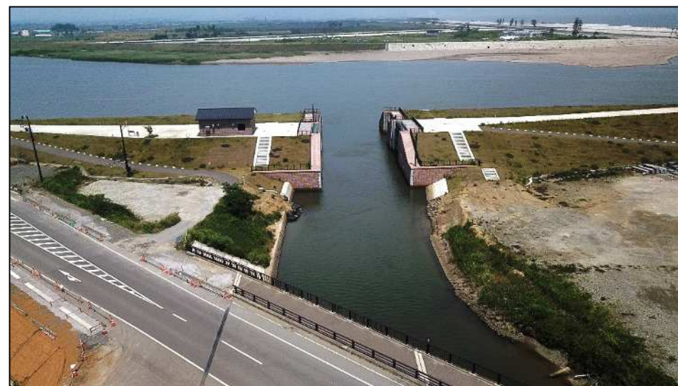
【野蒜水門 工事完成】
