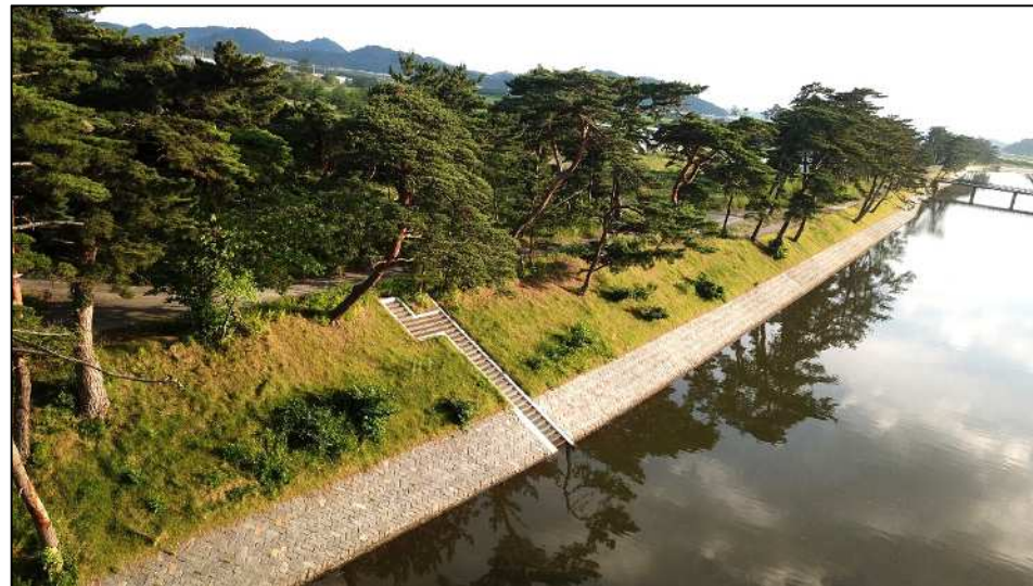
【東名運河 工事完成 松並木の保全】
