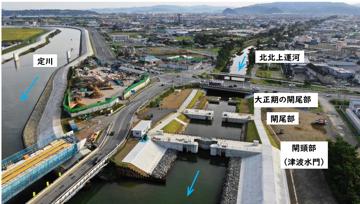
写真6.4.19 上空からみた釜閘門と周辺施設(復旧後)
