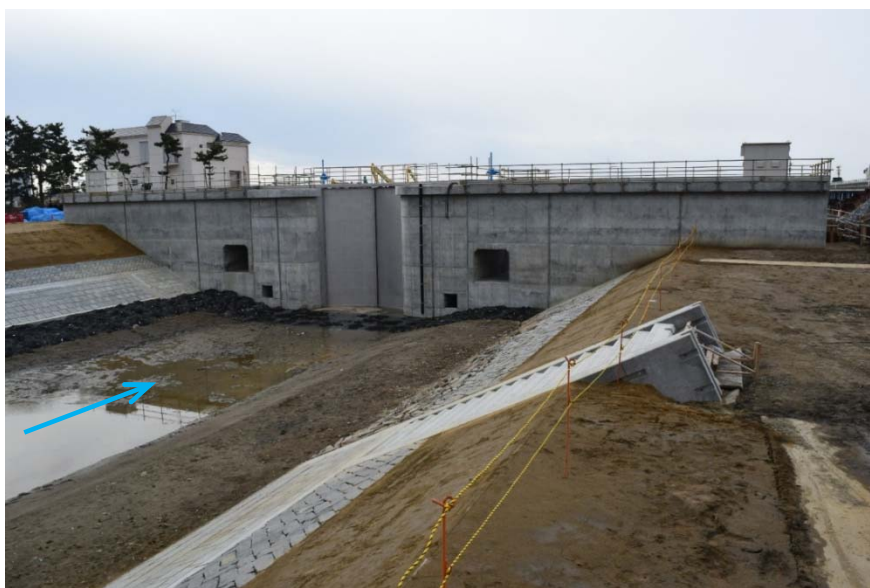
写真6.4.20 施設完成後通水前の釜閘門
