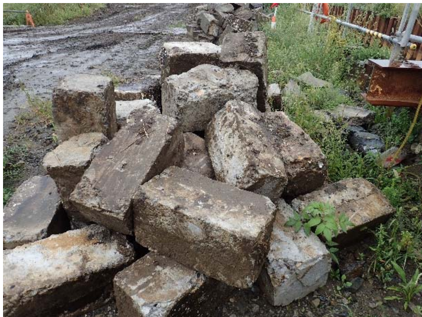
写真6.4.18 大正期閘門の解体時に現れたコンクリートブロック (このブロックが煉瓦のように積み上げられ、躯体を造り上げていました)
