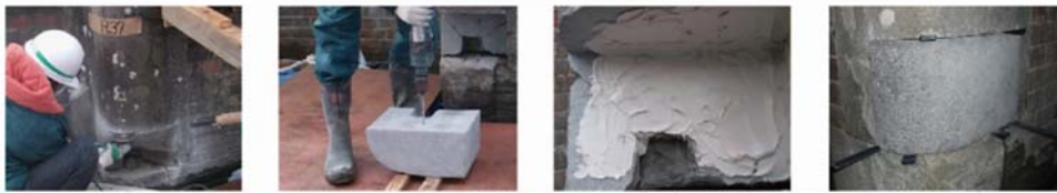
隅石の欠損部を取り除き、新材を取り除いた型に加工整形し、再設置
