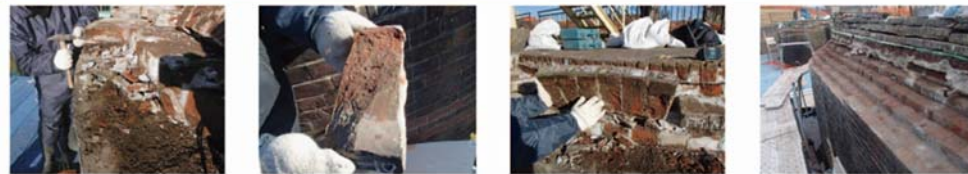
煉瓦損傷部分の取り外し
