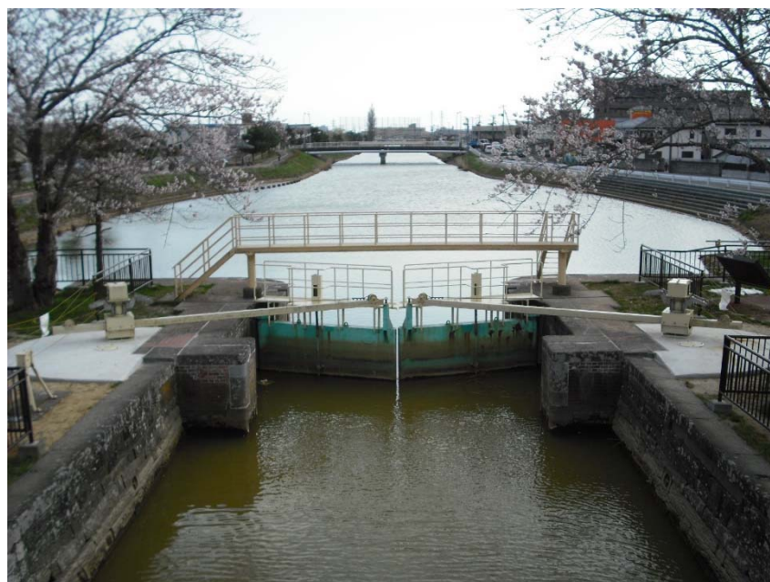
写真6.4.12 平成26(2014)年4月補修工事完了直後の石井閘門
