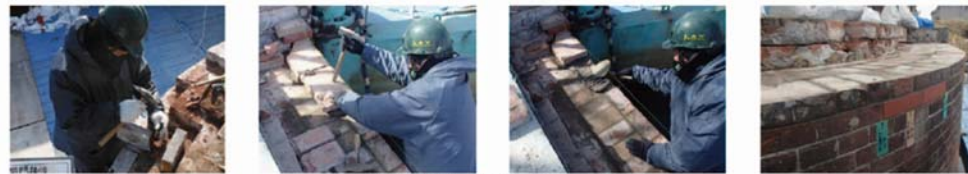
取り外した煉瓦をケレンし、再設置
