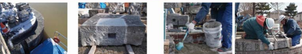
笠石の欠損部を取り除き、新材を取り除いた型に加工整形し、再設置
