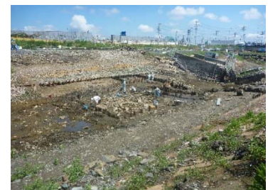
写真6.4.3 釜閘門の発掘状況
