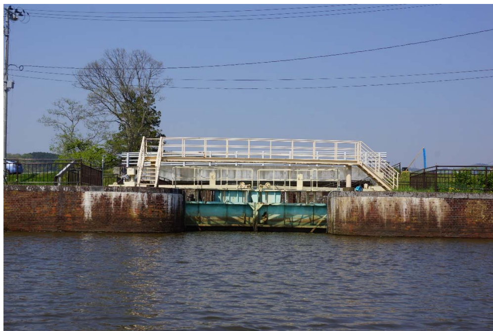
写真6.4.13 平成30(2018)年4月撮影の石井閘門
