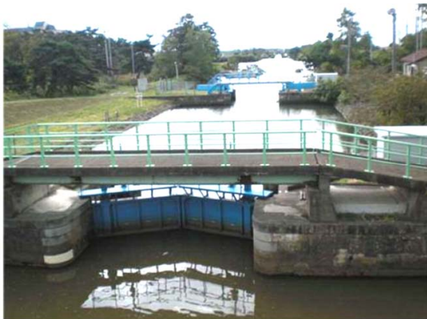
写真6.4.17 大正期の閘門(平成22年10月撮影)
