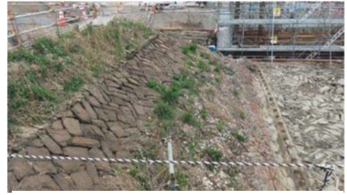
写真6.4.21 既設護岸存地部
