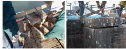
笠石の取り外し
