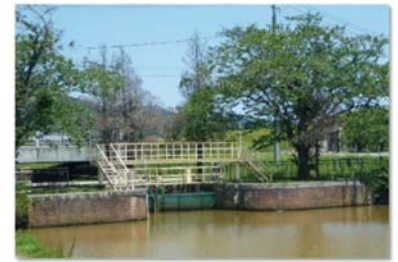
写真6.4.2 震災前の石井閘門
