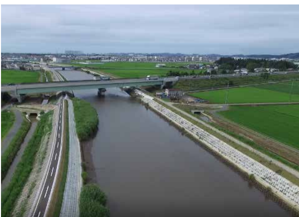
三陸自動車道上流から下流を望む
