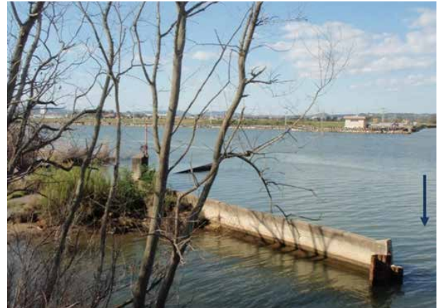
定川大橋上流部
