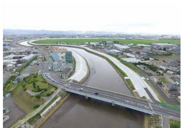
定川橋（国道45号）付近から下流を望む
