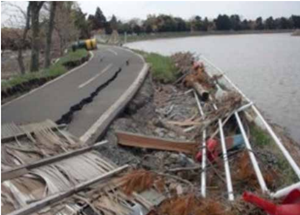
定川橋下流部
