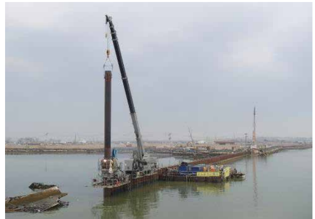
鋼管矢板打込状況
