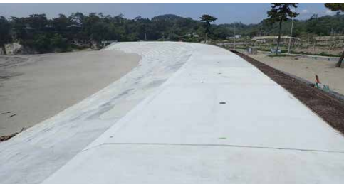
堤防全面 (海側)
