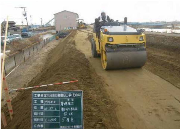
堤防盛土状況
