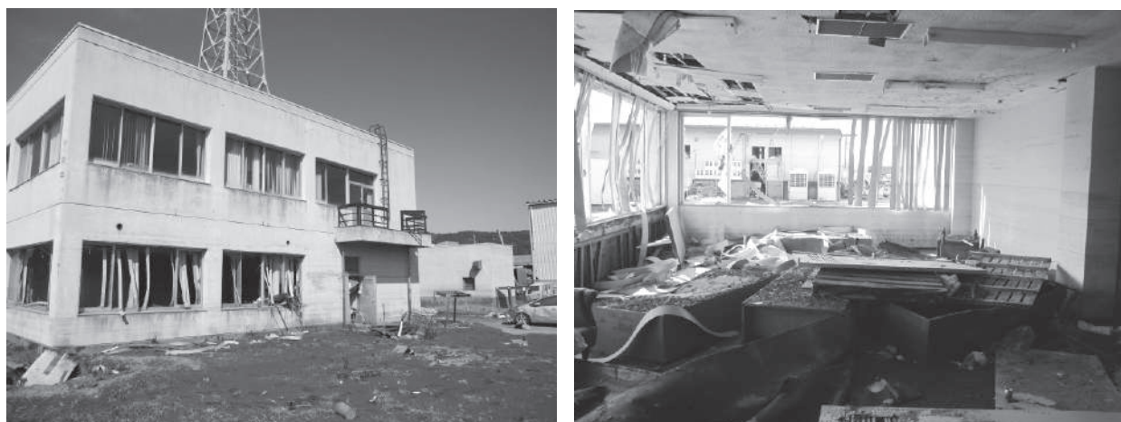
写真 津波で被災を受けた漁業無線局センター全景と建物内
