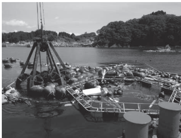
漁場に漂流・堆積したガレキを起重機船等で撤去
