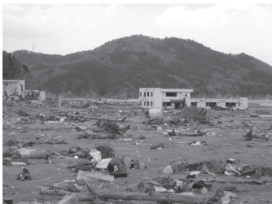
写真 谷川浜の種苗生産施設の被災状況
