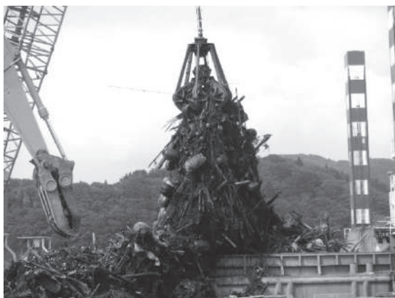
漁場に漂流・堆積したガレキを起重機船等で撤去
