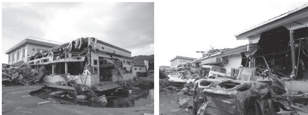
写真 水産加工開発部の被災状況
