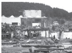
県漁協志津川支所施設
