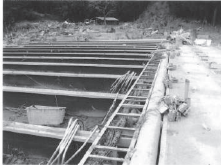
施工前 飼育池・アルミふ上槽
