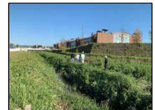
令和3年度雨水幹線改修(着工前)
