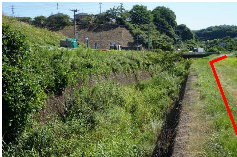
砂押川（宮城郡利府町沢乙地内）
