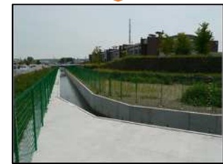
令和3年度雨水幹線改修(完成後)
