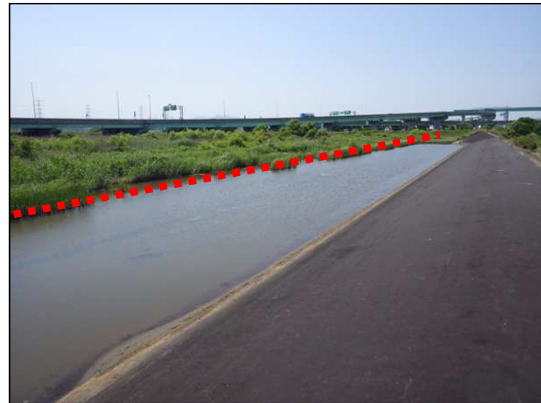
勿来川遊水地（多賀城市南宮地内）
