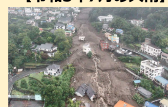
⑪土砂災害の状況 (静岡県熱海市)
