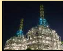
▲川崎天然ガス発電所
