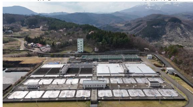
南部山浄水場
