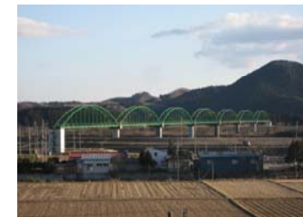
阿武隈川水管橋
