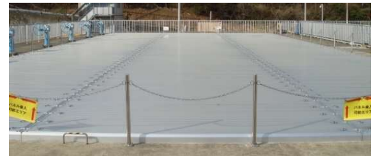
1系ブロック形成池覆蓋設置状況
