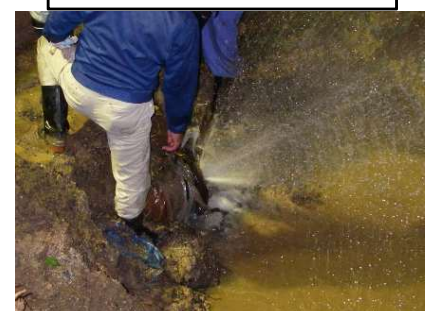
平成18年 角田市神次郎漏水状況 (継手部屈曲による抜け出し)
