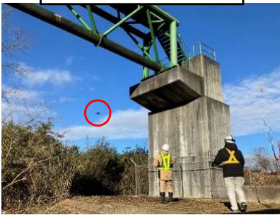
令和5年度 芋澤川水管橋 ドローン(○)による点検状況
