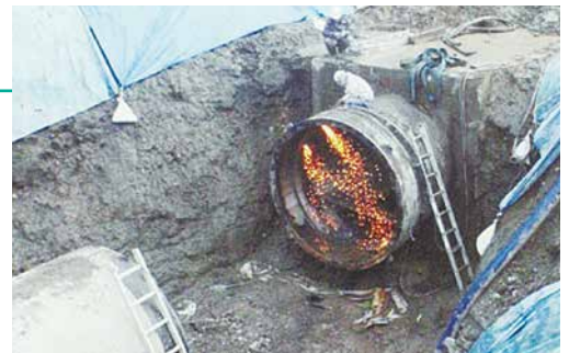
2,400mm送水管の漏水復旧工事
