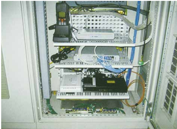
広域イーサネット回線を利用するためのルータ及び回線終端装置 (南部山浄水場管理本館)
