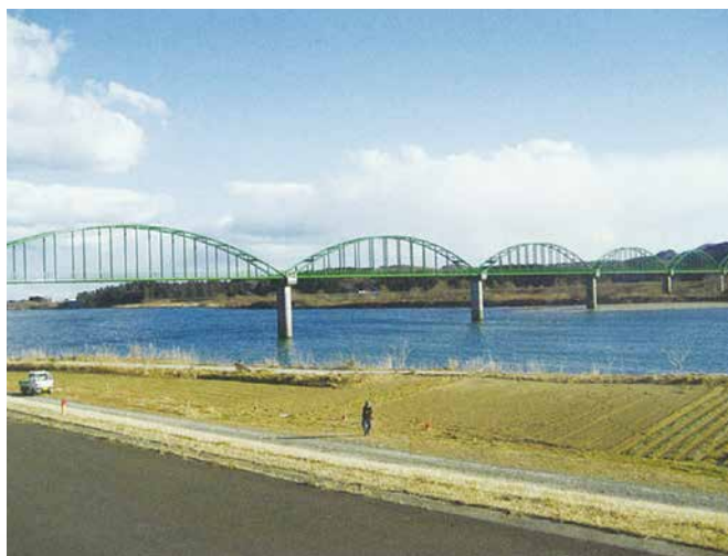
阿武隈川水管橋 (L=593m)
