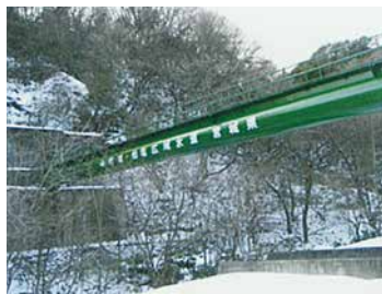
ガンド沢水管橋
