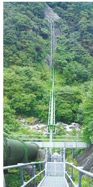
川原子沢水管橋
