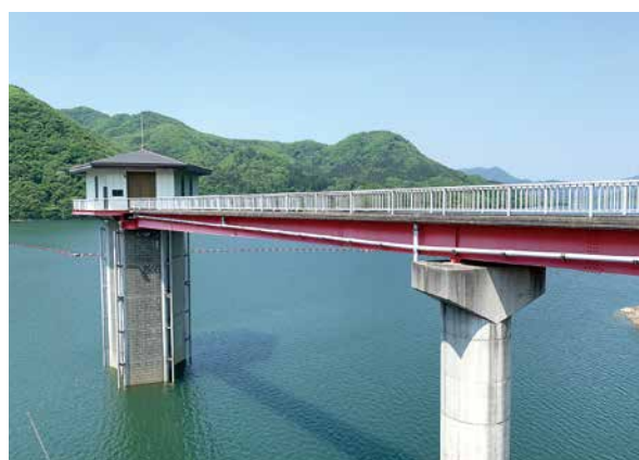
取水塔 (七ヶ宿ダム)
