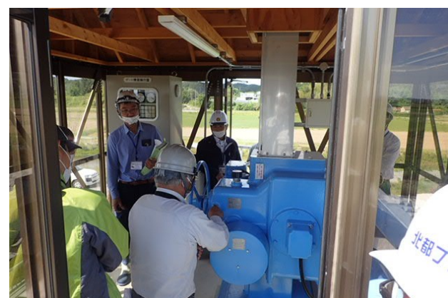
【佐賀川水門操作手順の確認状況】
