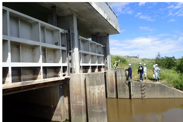
【百々川樋門の開閉操作・確認状況】
