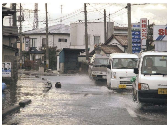
地盤沈下による道路冠水状況（1）
