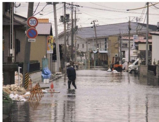
地盤沈下による道路冠水状況（2）
