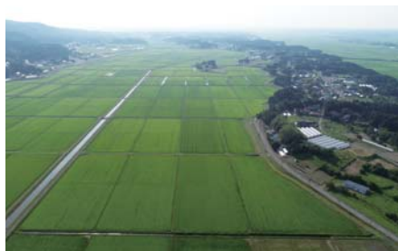
整備後(令和3年撮影)
