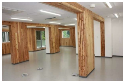
【事例1】株式会社コスモスウェブ（事務所） CLTパネル工法（ルート2） 県内初の3階建CLT建築
