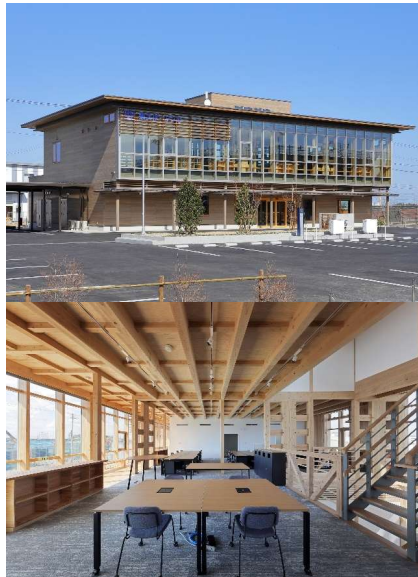
【事例2】東北ボーリング株式会社（事務所） 在来軸組工法+CLT CLTを2F床と屋根に活用
