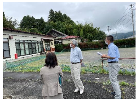
学校防災アドバイザーとの現地視察
