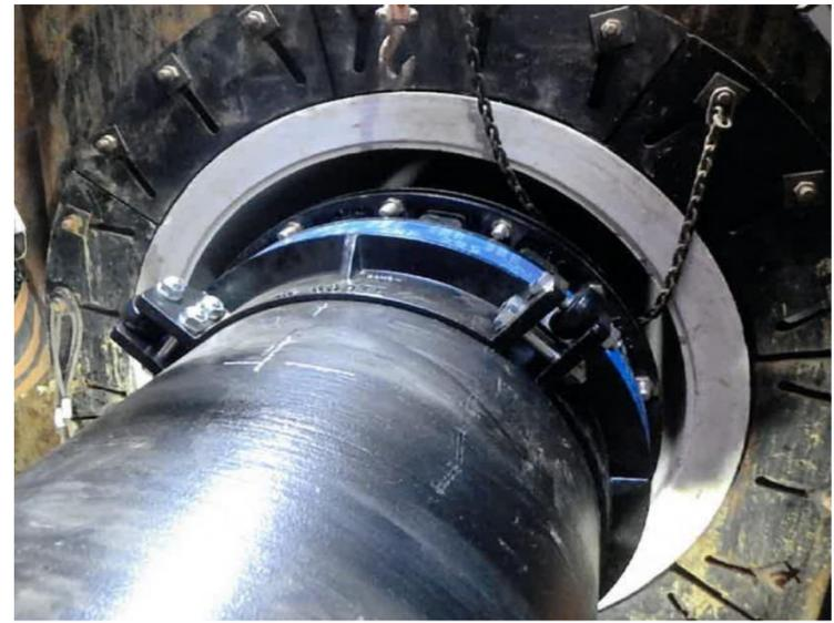
推進工による管接続完了状況
