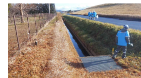
鹿島台浄化センター周辺実施状況
