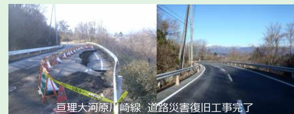
巨理大河原川崎線 道路災害復旧工事完了
