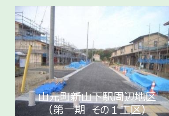
山元町新山下駅周辺地区 (第一期 その1工区)
