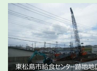
東松島市給食センター跡地地区
