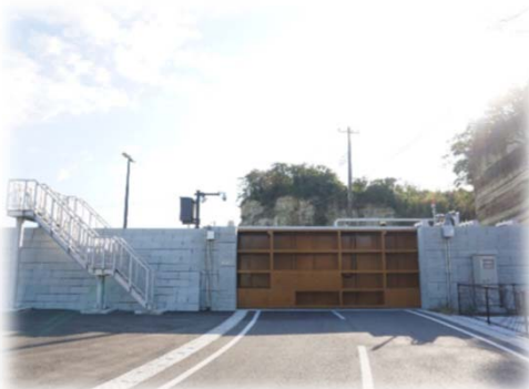
花淵浜吉田浜地区 吉田花淵防潮堤 (七ヶ浜町)
