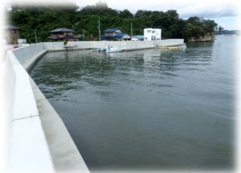
東宮浜代ヶ崎浜地区 小友浜護岸 (七ヶ浜町)
