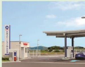
イワタニ水素ステーション仙台空港
