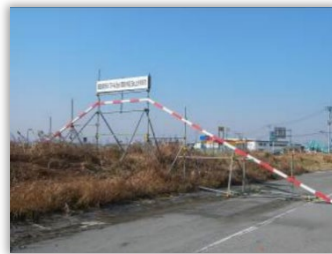
海岸堤防・河川堤防完成イメージ丁張設置状況（宮城県）
