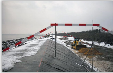
海岸堤防・河川堤防完成イメージ丁張設置状況（宮城県）
