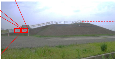
宅地・市道の嵩上げイメージ設置状況（名取市閉上地区）
