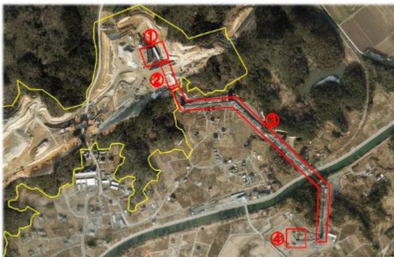
ベルトコンベア全景【平成 26（2014）年 1 月～10 月稼働】 ①破砕機投入口 ②トンネル部分（完成後は野蒜駅連絡通路となる） ③搬送路 ④最終落とし口
