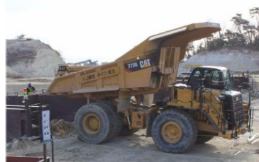
50t ダンプ・30t ダンプにより大量の土砂をベルトコンベアの破砕搬入口へ運搬（写真は 50t ダンプ）
