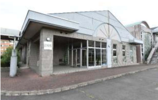
② 2号館実習棟（運動場側から撮影）
