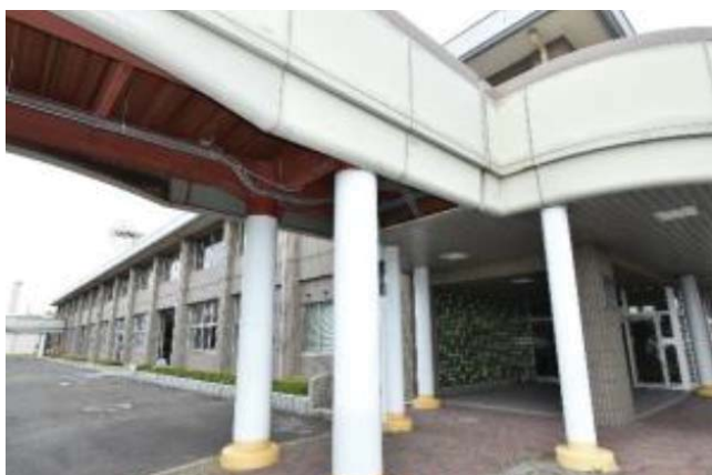
④ 4号館実習棟（運動場側から撮影）
