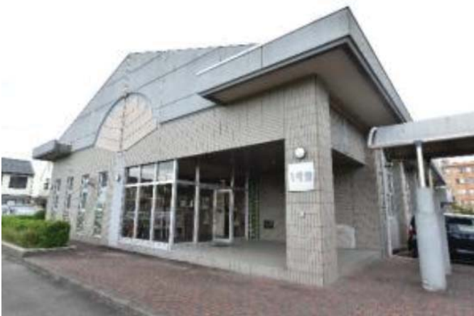
① 1号館実習棟（運動場側から撮影）
