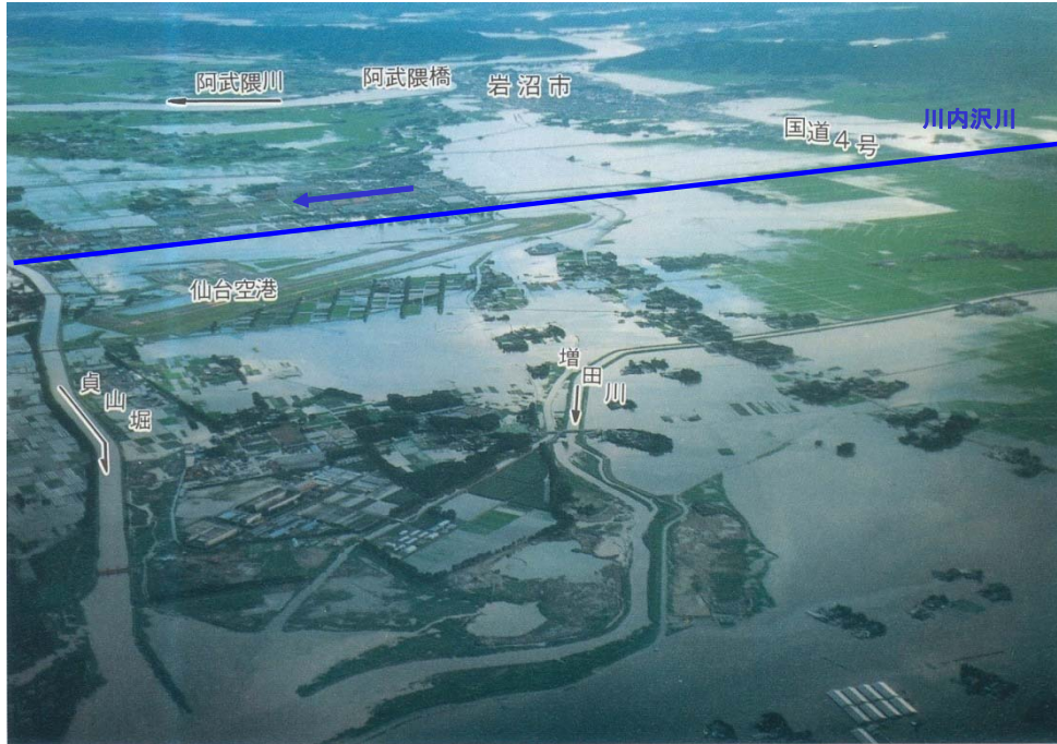
○平成6年9月22日洪水状況（川内沢川下流）
