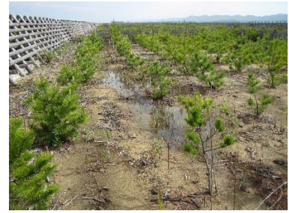
図2 盛土上の排水不良
