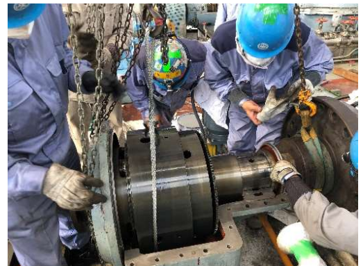
▲山吉田揚水機場1号ポンプ 減速機分解調査状況
