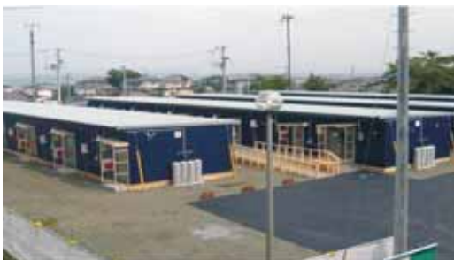
仮設住宅（塩竈市）
