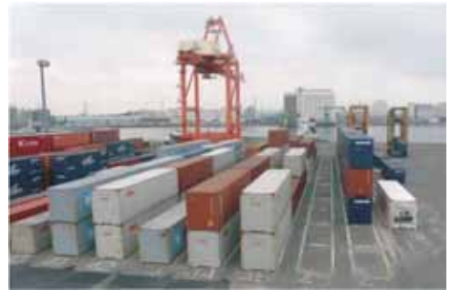
仙台塩釜港 高砂埠頭（復旧状況）
