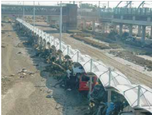
仙台空港（被害状況）
