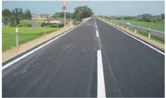
迫川 栗原市若柳大林地内（復旧状況）
