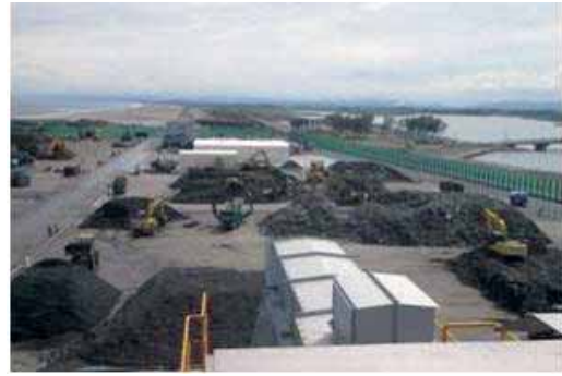
破碎選別ヤード（亶理名取ブロック）
