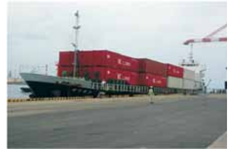
仙台塩釜港 高砂埠頭（復旧状況）
