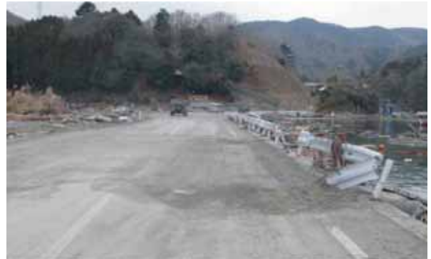
女川牡鹿線（復旧状況）
