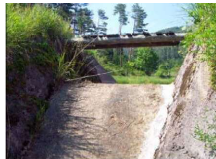
洪水吐の補修
