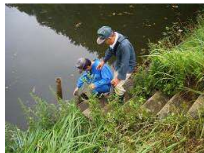
取水施設の点検
