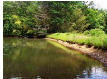
堤体が洗掘されているため池
