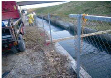
金網フェンスの 設置
