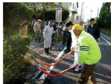
水路蓋の設置 (専用器具使用)
