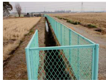
新たに設置された 金網フェンス
