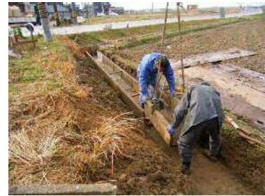
水路の再布設
