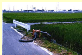
ポンプアップ状況
