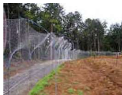
防護柵設置状況
