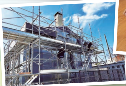
足場の組立て訓練
