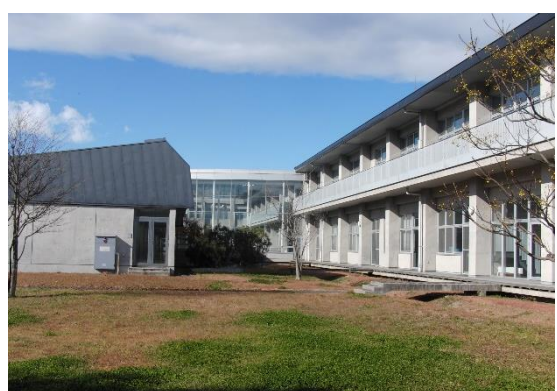
④ 実習棟A・B
