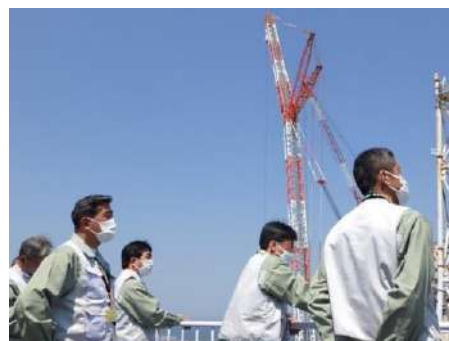
図5-6 東京電力福島第一原子力発電所 現地調査（令和5年6月7日）
