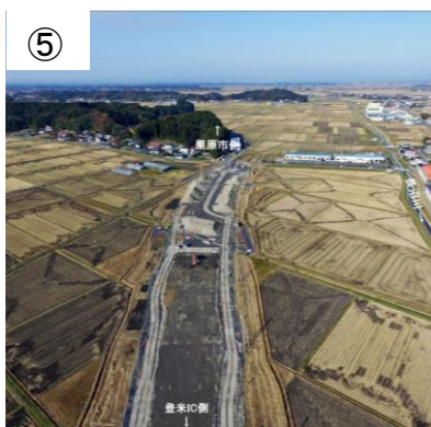
国道398号付近の地盤改良状況
