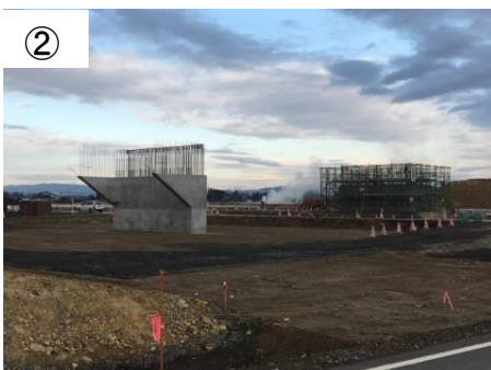
(仮)中田IC 橋台施工状況
