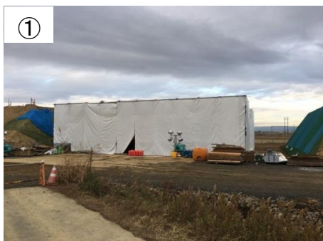
5号函渠施工状況
