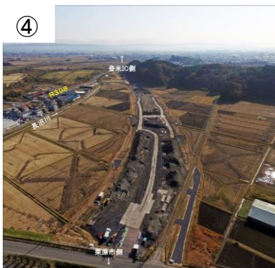
国道398号付近の地盤改良状況
