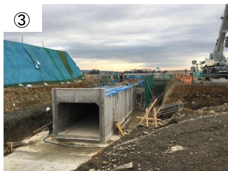
9号函渠の施工状況
