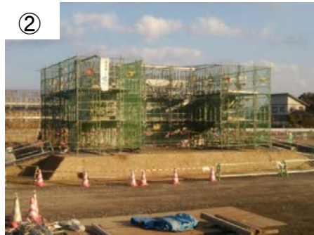
② (仮) 中田IC A1橋台部分の施工状況
