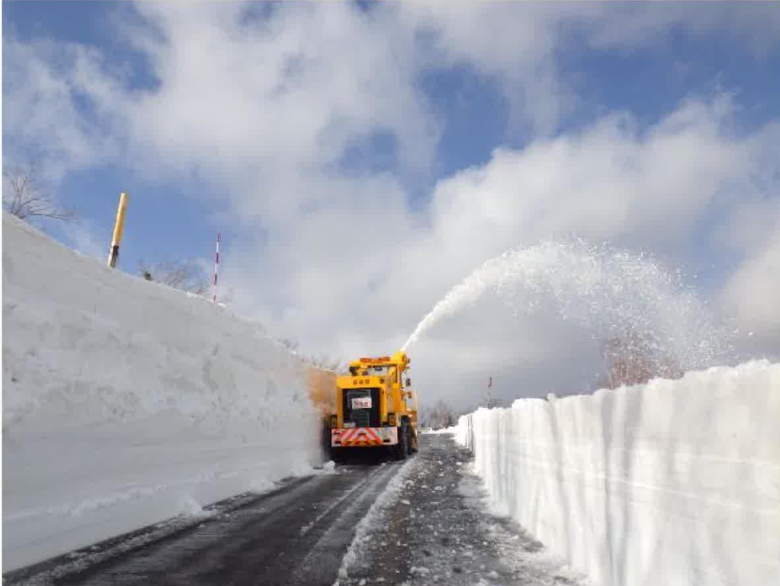
蔵王エコーライン(主要地方道 白石上山線) 除雪状況
