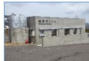
蔵王トイレ再整備 (駒草平)
