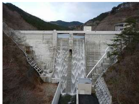
写真 3.13 払川ダム 近景（南三陸町）
