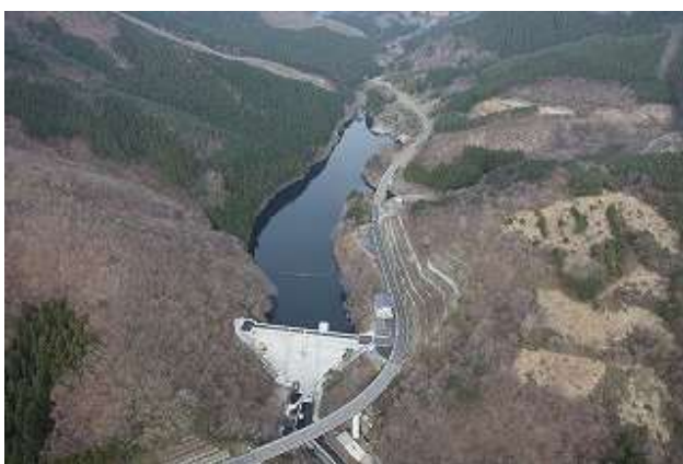
写真 3.12 払川ダム 全景（南三陸町）
