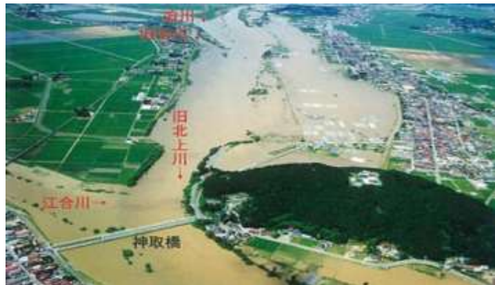
写真 3.7 2002 年 7 月洪水の状況（旧北上川氾濫状況）
